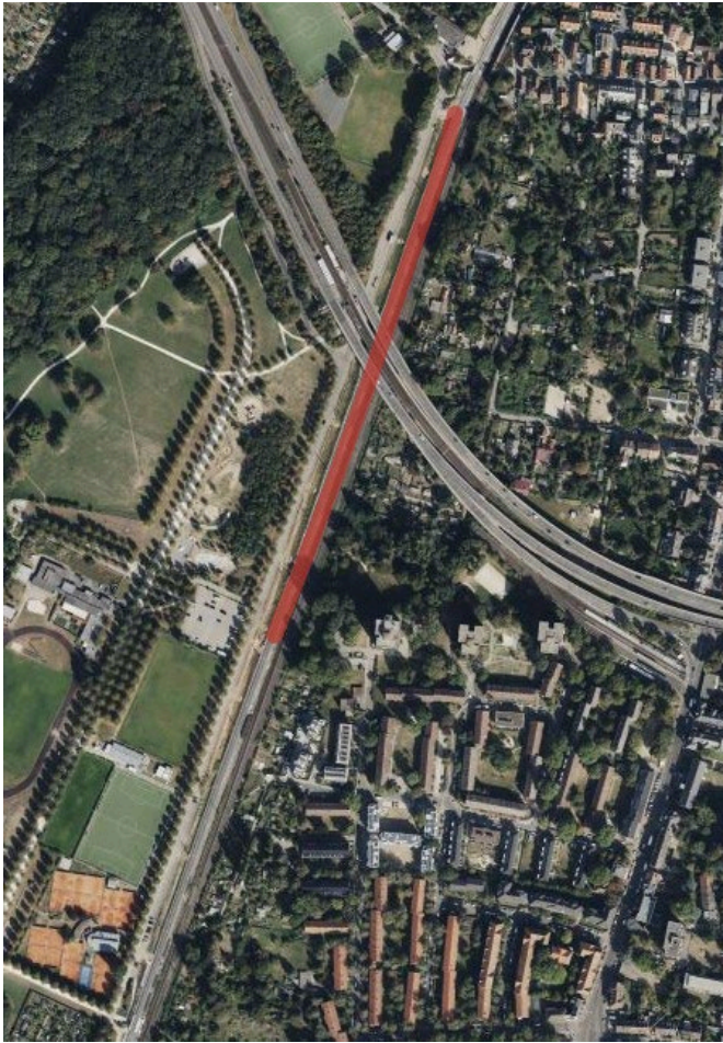
Arbeitsbereich Bahnkilometer 193,3 -193,8 (Quelle Luftbild: https://www.bing.com/maps )
