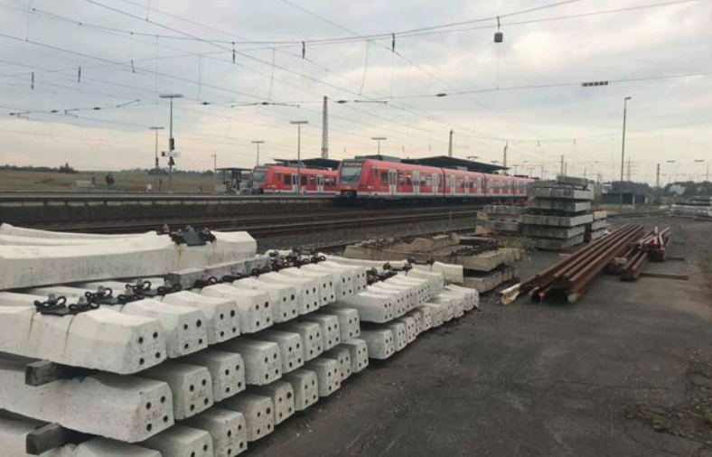
In Bad Vilbel liegen bereits die Bauweichen für den Einbau bereit.
